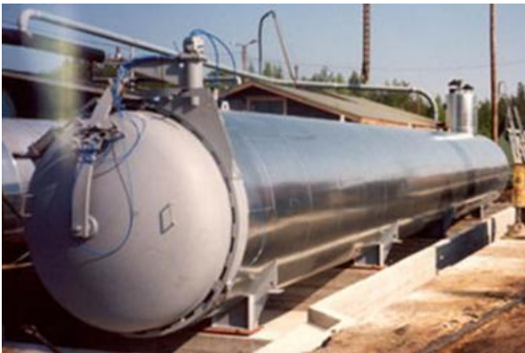
写真 2.2.2 a 加圧注入保存処理施設
