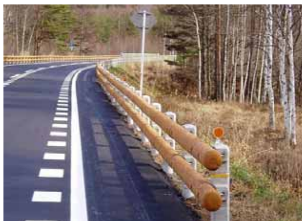
写真 2.3.5 木製防護柵設置現場写真
