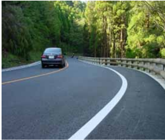
宮崎県 県道1号線 小林
