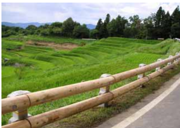
写真 2.3.5 木製防護柵設置現場写真
