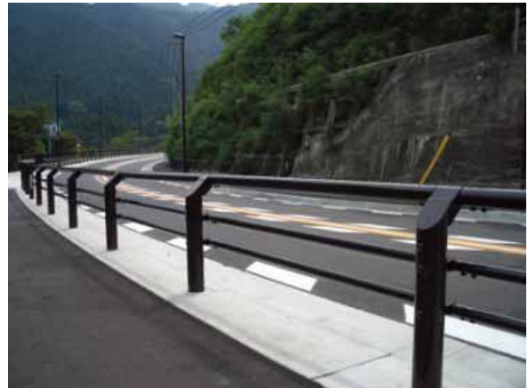
写真 2.3.4 景観ガードパイプ（三連）
