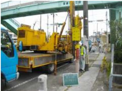
写真8 宮崎現場 先行孔削孔
